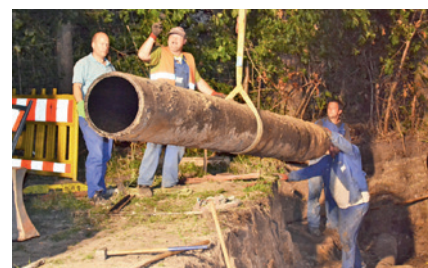
Stück für Stück: Das Schmutzwasser-Kanalnetz des ZVO wird langfristig renoviert.
